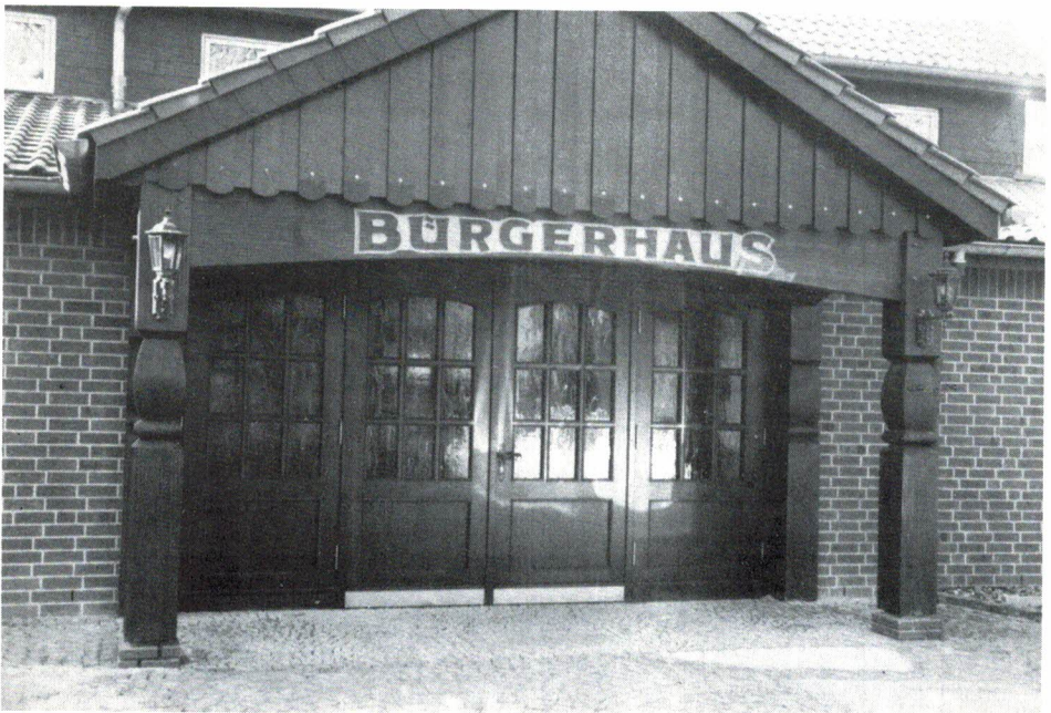
Eingang zur Halle des Bürgerhauses
